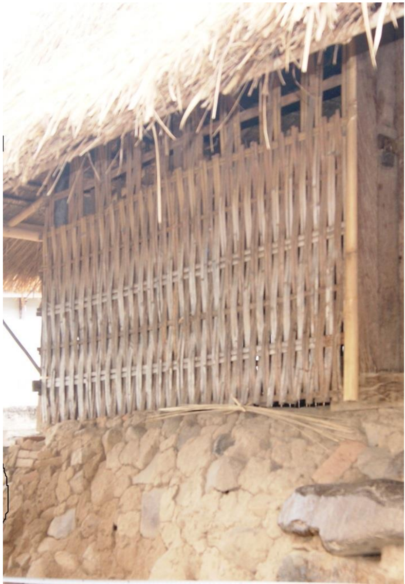
Dinding dengan ventilasi
