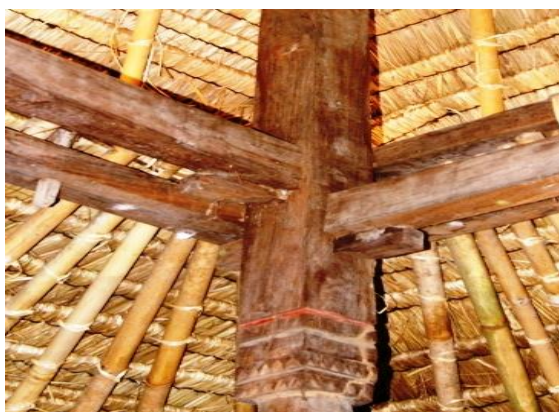
Model sambungan kayu tidak menggunakan besi atau paku
