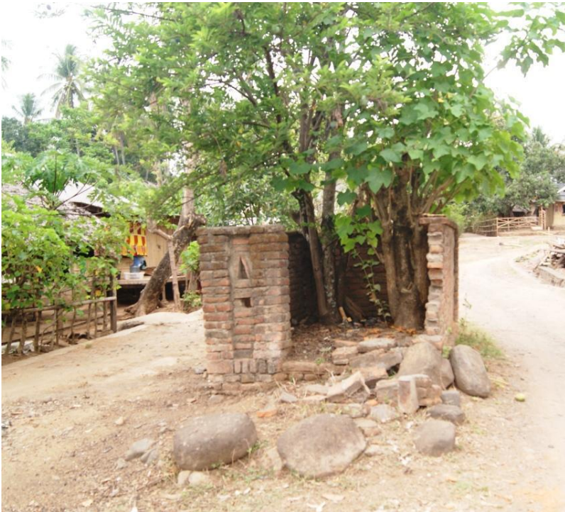
Lokasi yang dijadikan titik bangar
