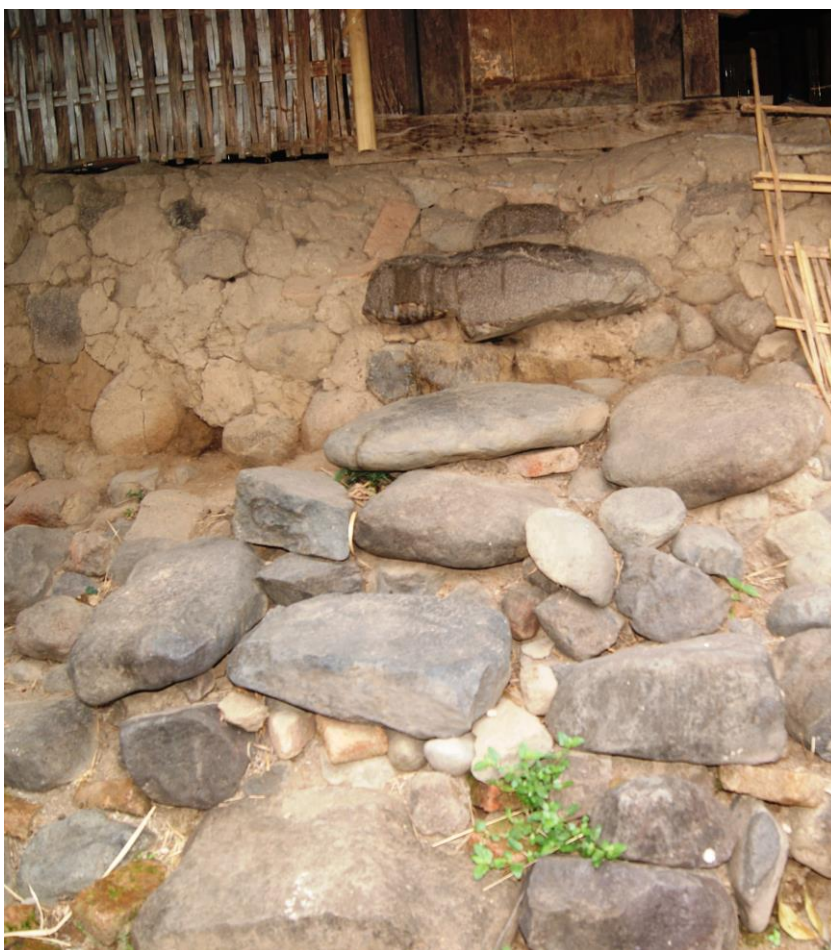
Susunan batu sebagai tangga pintu masuk yang bersusun lima
