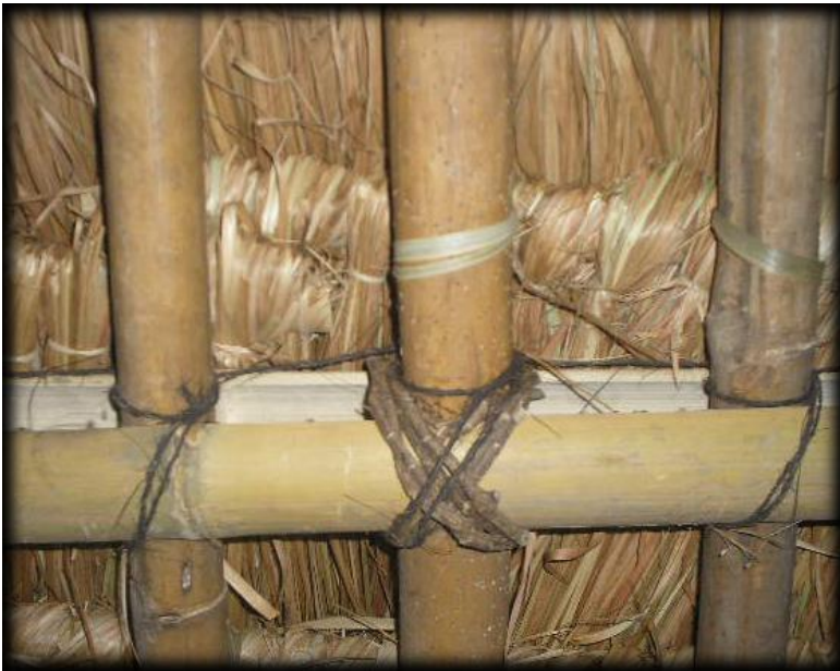
Gambar 16. Penggunaan tali pada setiap sambungan (ikatan) tidak menggunakan paku
