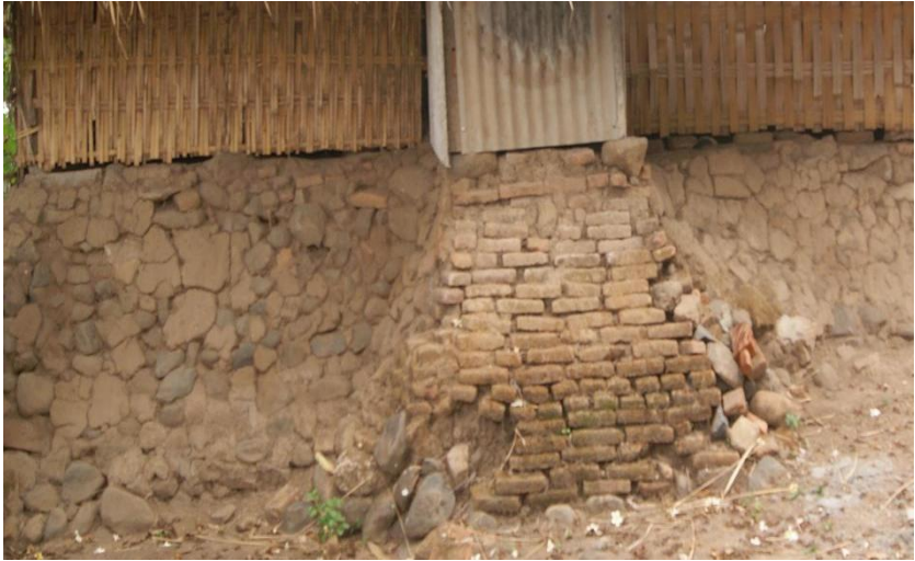
Gambar 7. Pondasi mesjid tampak depan mihrab
