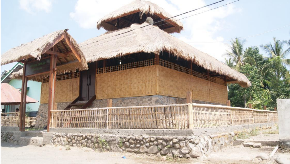
Gambar 7. Mesjid Kuno Sesait setelah pemugaran, yang dibangun oleh penyebar Islam awal
