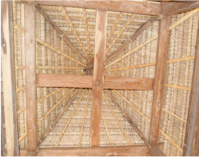
Gambar 15. Atap bagian atas, tampak dari dalam dengan usuk 25 buah
