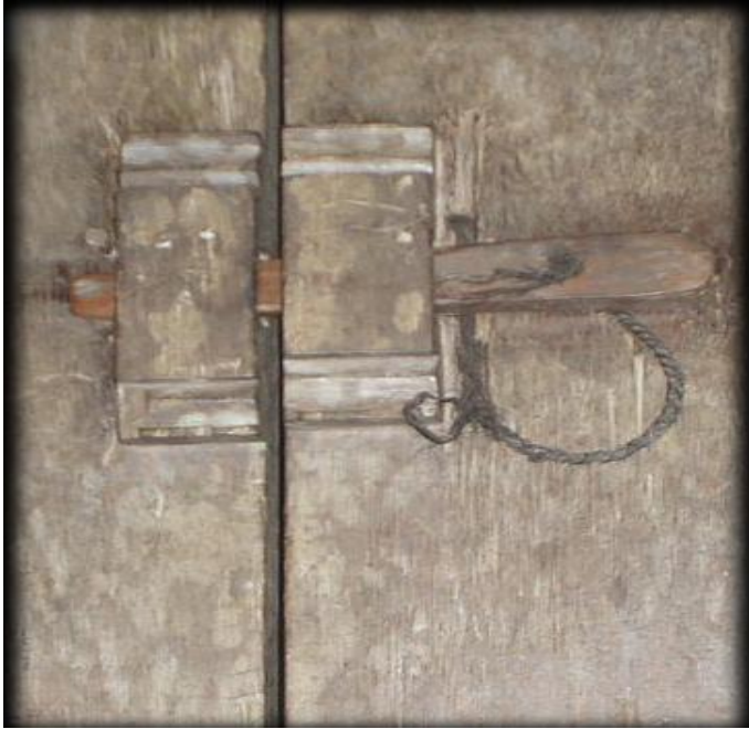
Gambar 13. Engsel Pelocok di pintu mesjid
