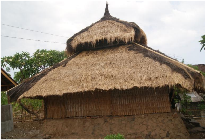
Gambar 4. Tampak samping kiri diambil dari arah selatan, atap tumpang
