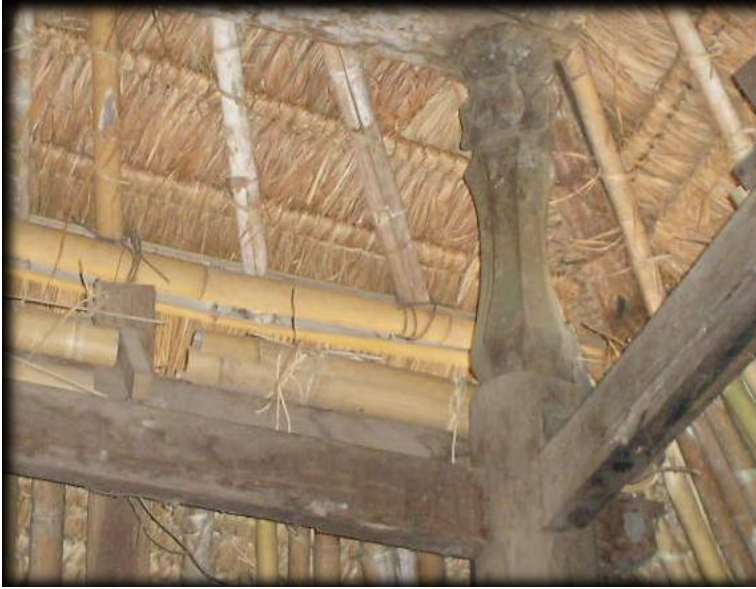
Gambar 17. Sambungan-sambungan tidak menggunakan Paku
