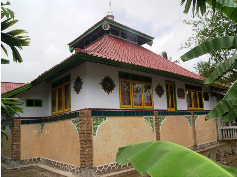
Gambar 5. Masjid Sumbek setelah direnovasi, tampak dari samping kiri, dasar bangunan yang tinggi berwarna coklat muda (ini bukan tembok keliling), dengan atap dari genteng
